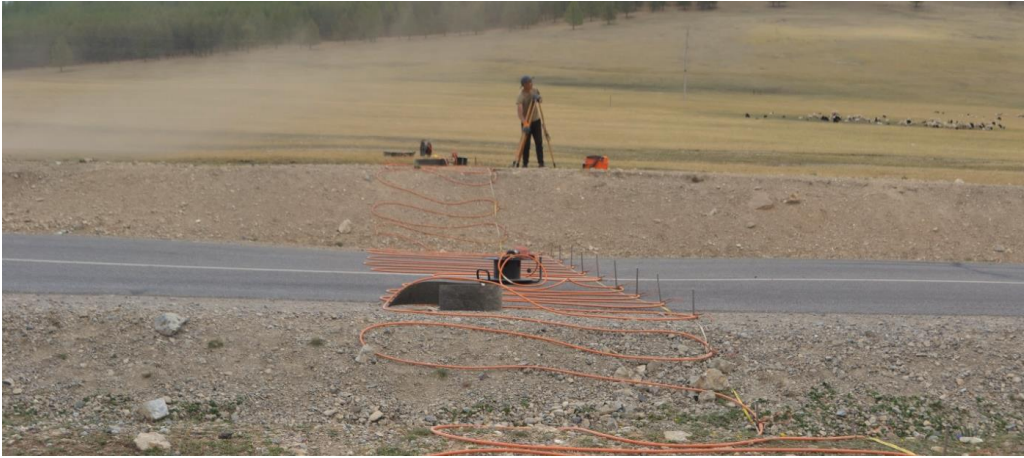
Зураг 2. Туршилт хийх авто замд хөндлөн огтлолоор геофизикийн хэмжилт хийж байгаа нь
