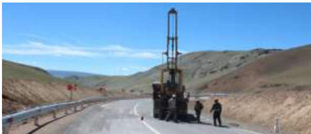
Зураг 9 . 78+980 : K79+240 зурваст өрөмдлөг хийж буй нь.
