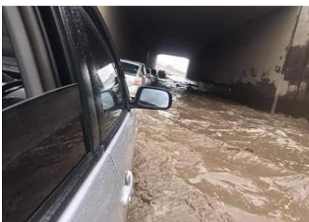
Зураг-14. 2021.06.08 Ярмагийн шинэ гүүрний нүхэн гарц /эх сурвалж unuudur.mn/
