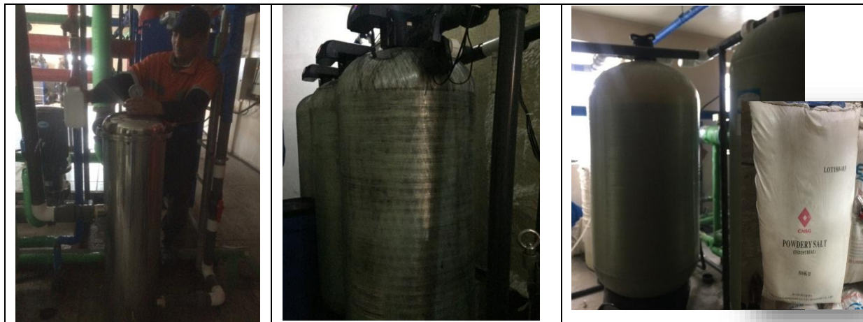
Фото зураг 1. Жарден, Түшээ гүн, Энхжин хотхонуудад суурилуулсан шүүлтүүрүүд
