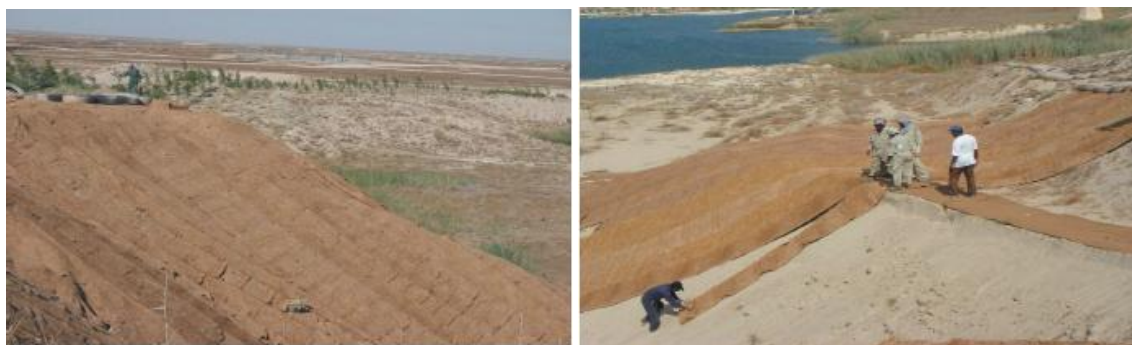
Зураг 5, 6. КОС-д сул элсний нүүдлийг зогсооход эко хивсийг ашигласан байдаг (Арабын Шинжлэх ухааны Зөвлөх Төв,Кувейт), 2006 оны 11 дүгээр сар.
